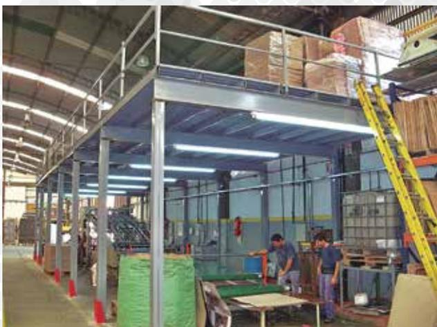
**Totalmente modular y desarmable, permiten la construcción parcializada, como así también su desarmado y reubicación. Su instalación es rápida y limpia, ya que no requiere trabajos de albañilería y no se fija a paredes o vigas. Aptos para depósitos con almacenado previo de mercadería.**
